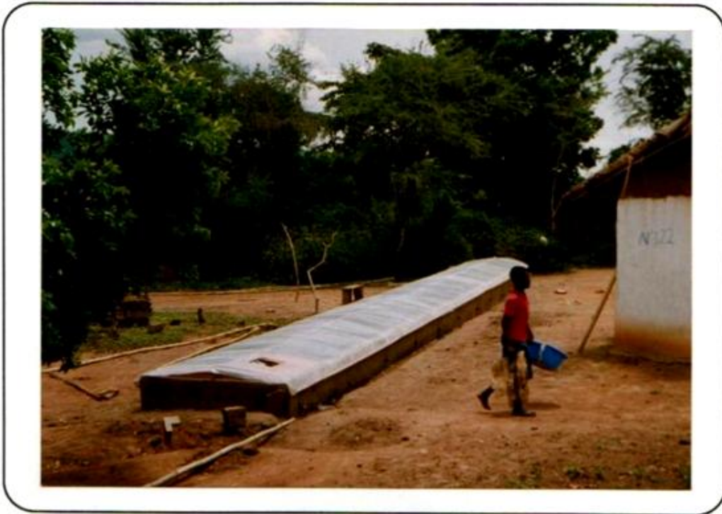
Le séchoir fini est aéré par un ventilateur de voiture. Celui-ci reçoit son énergie d'un module solaire de 50 Watt.
